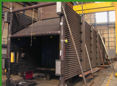
Construcció de la caldera de combustió
